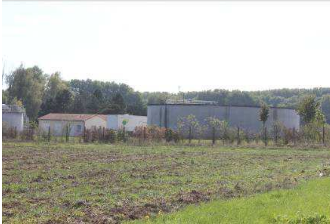
Station d'épuration du bourg
